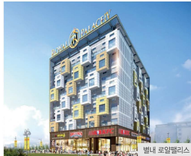
대구울하2아파트 전기공사 1공구
