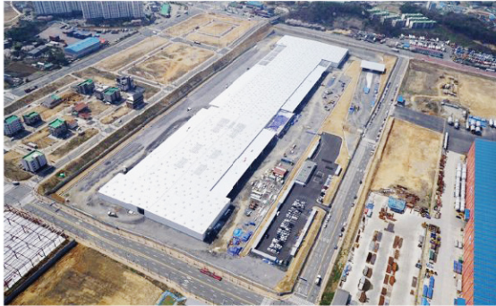
코스트코 평택디포 신축공사 중 전기공사
